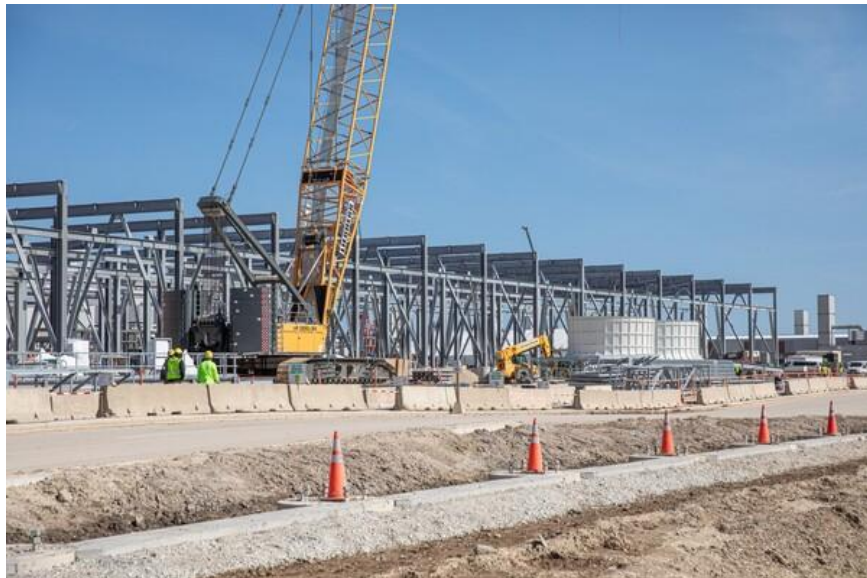
마이크로소프트 데이터센터 프로젝트 공사 현장 / 마이크로소프트
