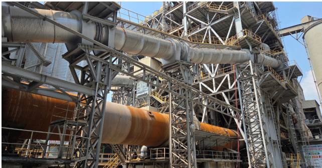
철강슬래그를 활용한 시멘트 제조 현장
