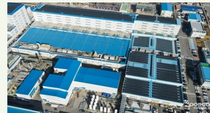
광양 양극재 공장 태양광 발전 설비
