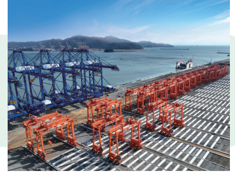
부산신항 2-5단계 트랜스퍼 크레인
