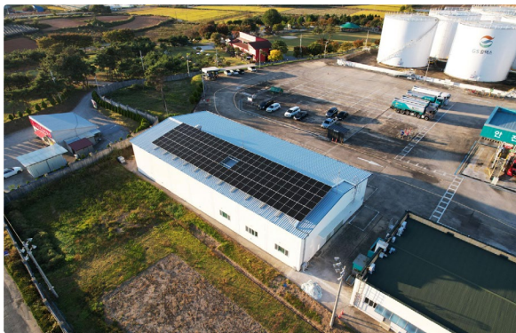
GS칼텍스 전주 물류센터 태양광 발전시설
