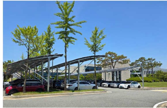
GS칼텍스 기술연구소 주차장 태양광 발전시설
