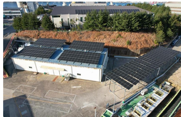
GS칼텍스 창원 물류센터 태양광 발전시설
