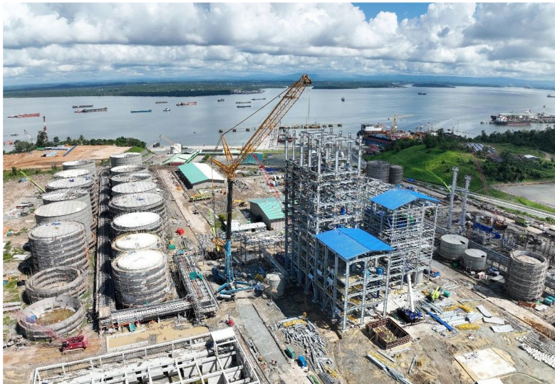
ARC 법인 바이오 원료 정제시설 건설 현장
